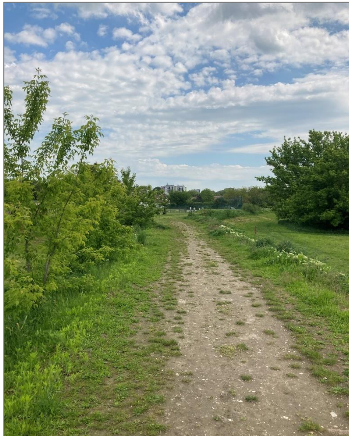
4. Árvízvédelmi töltés a kerékpárút mentén
