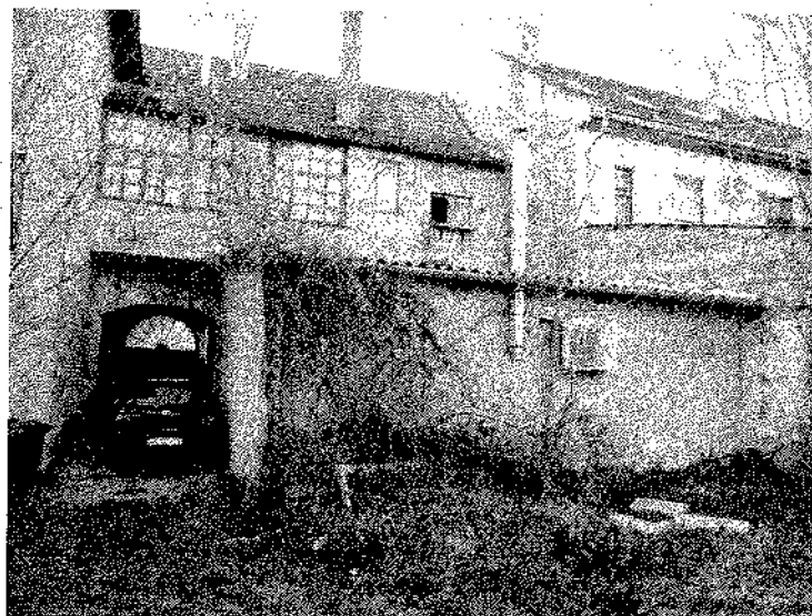
Belső oldali, udvari homlokzat
