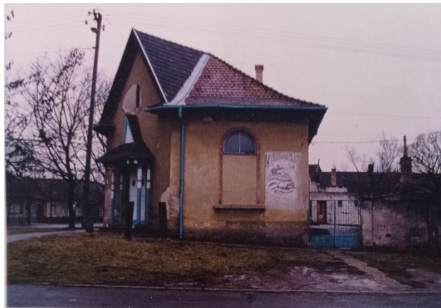
Kálvin utcai homlokzat
